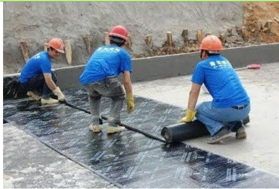
Contoh pemasangan waterproof membrane di atas bumbung Sumber : http://video-images.vice.com
